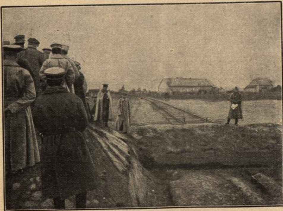
Standort eines 42-cm-Geschützes während der Beschießung von Antwerpen. Die gewaltigen Mörser werden auf Geleisen nach den vorher fertig gestellten, mit starken Betonfundamenten versehenen Standorten gebracht. Nach drei Tagen sind sie dann schußbereit.
