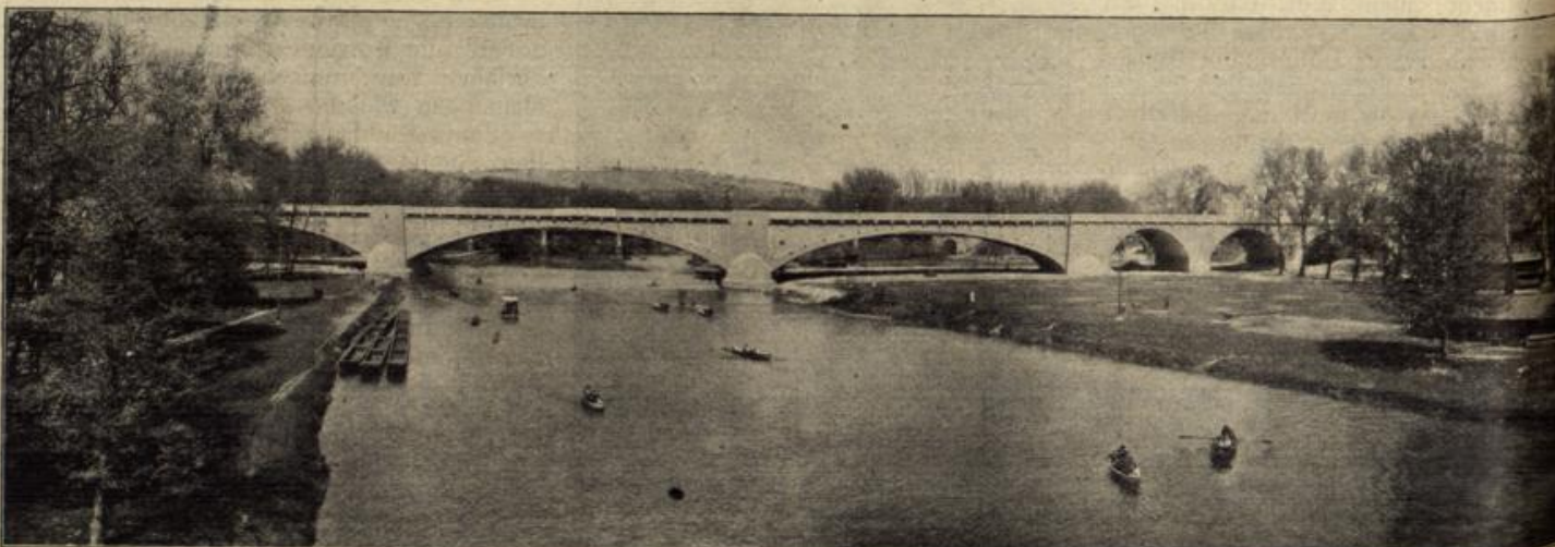
Die neue Eisenbahnbrücke in Cannstatt. Emil Nicolai, Cannstatt, phot. (Mit Text.)
