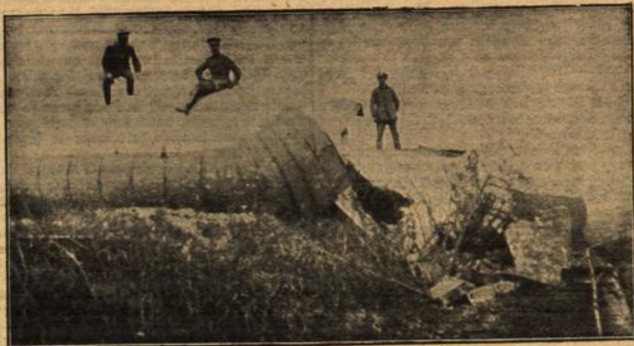
Die Wirkung der 42 cm-Mörser von Krupp und Skoda an den Forts von Przemysl: die 30 Meter weit weggeschleuderte Kuppel eines Geschützturnes auf Fort 11.
