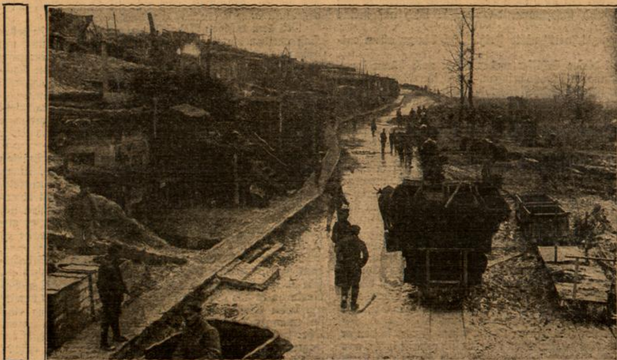
Ein von unseren Truppen erbautes Hanglager mit Bürgersteigen und Straßenbahnen zur Materialbeförderung in die vordersten Gräben.
