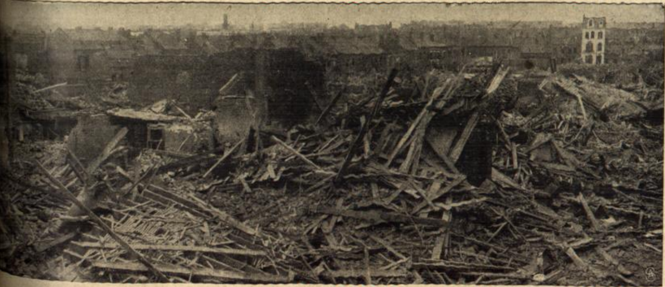
Von den Durchbruchskämpfen an der Westfront: Die Zerstörung der nordfranzösischen Industriestadt Lens durch englisches Artilleriefeuer.
