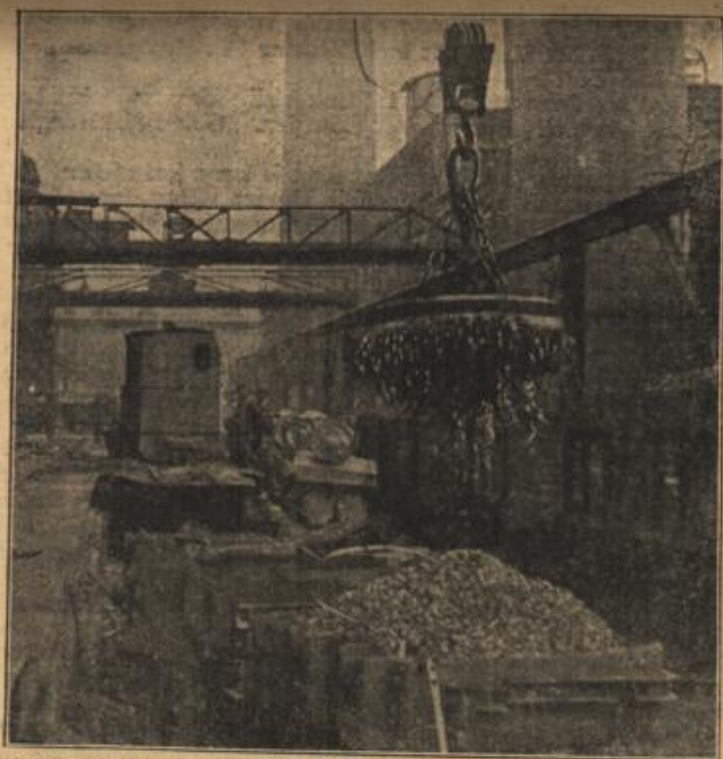
Elektrischer Magnetkran beim Beladen von Eisenspänen. (Mit Text.) (K. u. I. Kriegsministerium.)
