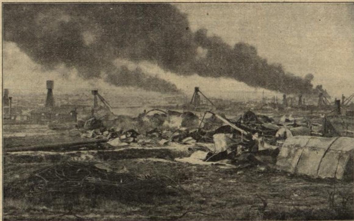
Brennende Naphthagruben in Boryslaw, im Vordergrund zerstörte Bohrtürme. (Mit Text.)
