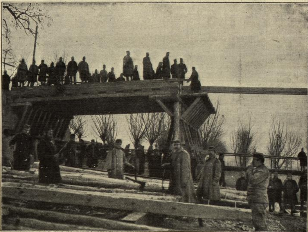
Österreichisch-ungarische Pioniere beim Brückenbau. (S. 68)
