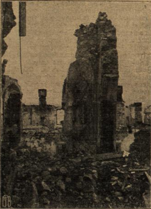
Reste einer Außenwand der Klosterkirche auf dem Monte Santo bei Görz. (Mit Text.)
