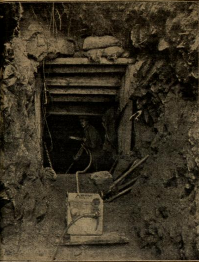
Minenkämpfen in den Vogesen: Elektrischer Gesteinsbohrer am Felsen. Phot. Wipperling. (Zentert Generalstab.)
