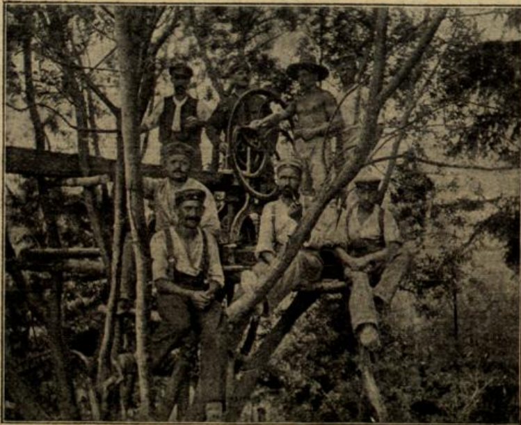
Pumpvorrichtung zum Entwässern und Trockenhalten von Schützengraben.
