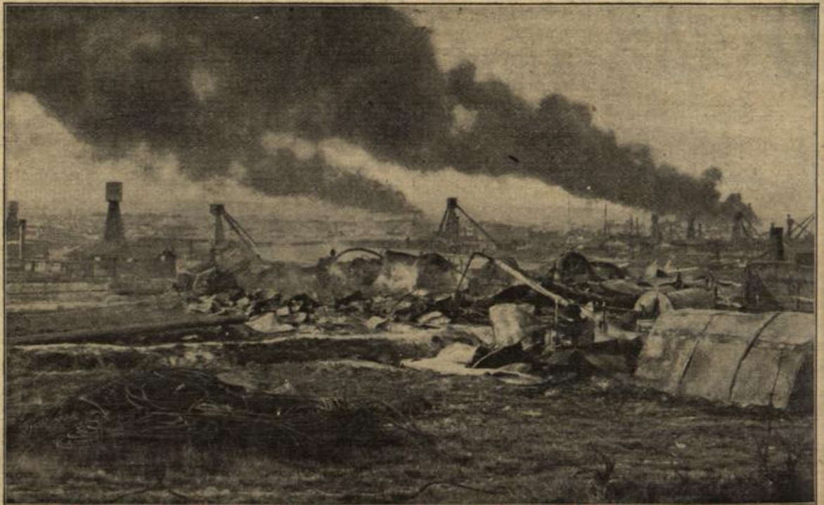
Brennende Naphthagruben in Boryslaw, im Vordergrund zerstörte Bohrtürme. (Mit Text.)
