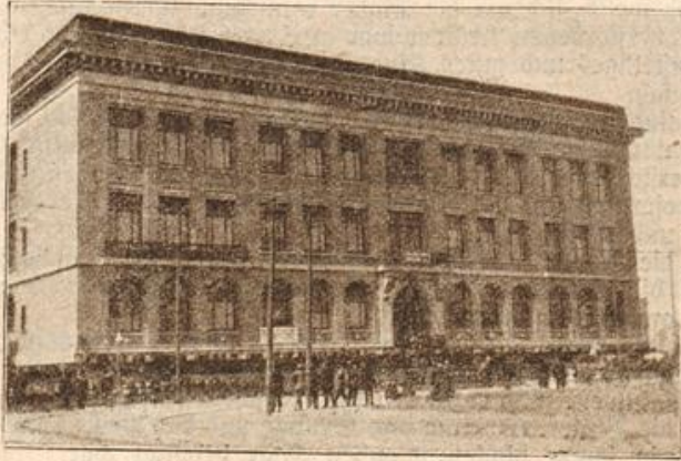
Transport eines dreistöckigen Hauses in San Franzisko. Phot. A. Vassie, San Franzisko. (Mit Text.)
