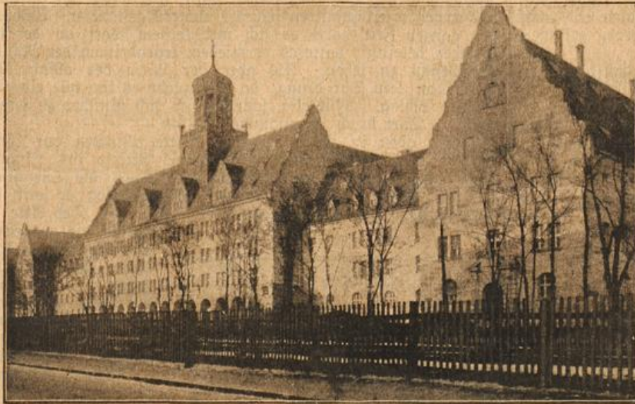
Das neue Justizgebäude in Nürnberg.
